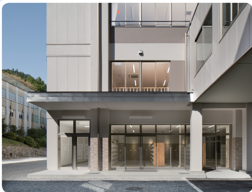
第一期工事完成 昇降口アプローチ
